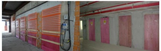
Figura 18 - Fechamento das Aberturas de Acesso aos Locais dos Futuros Elevadores
