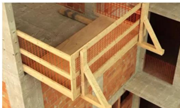
Figura 16 - GcR em Plataforma em Balanço
